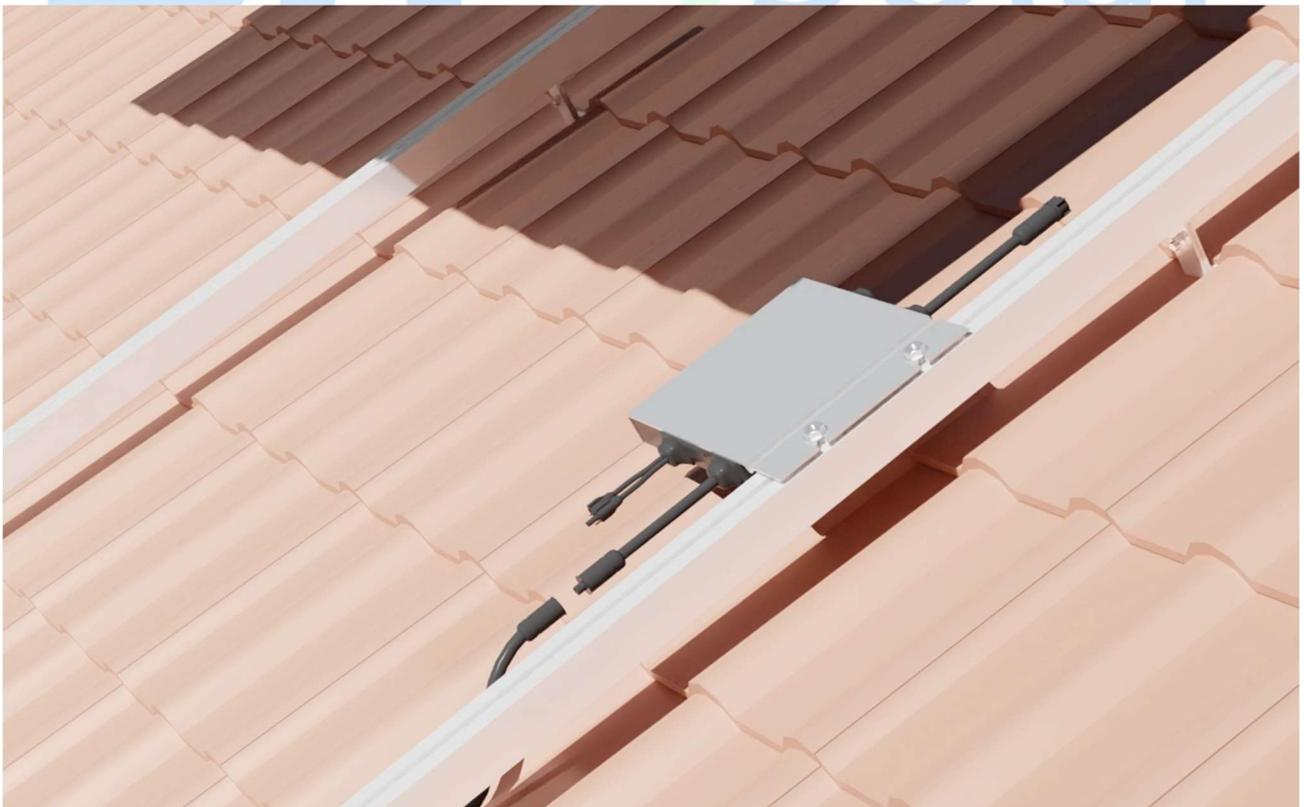
8. Verbinden Sie nun das AC-Ausgangskabel wie gezeigt mit dem Wechselrichter:
