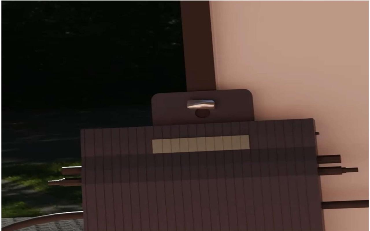
9. Verbinden Sie nun wie gezeigt die 2 DC-Ausgangskabel des Moduls mit dem Wechselrichter:
