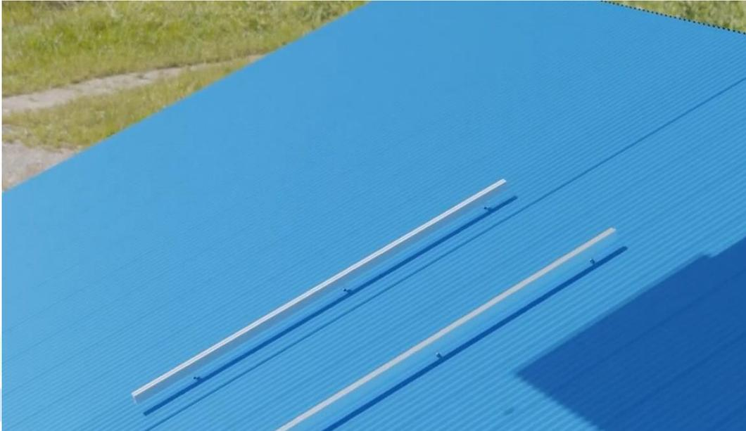
6. Verbinden Sie nun die Aluminiumprofile innerhalb derselben Umrandung und schrauben Sie sie mithilfe von Profilverbinder wie in den folgenden Bildern gezeigt.
